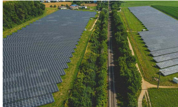
Solarpark Zwiefalten der enBW, Inbetriebnahme 2017 Leistung und Fläche: 5,2 MWp auf 7 ha (5.800 MWh/a)
