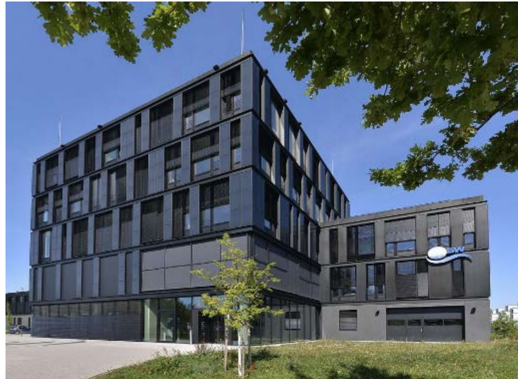
➤ ZSW-Gebäude in Stuttgart-Vaihingen (STEP) mit PV Fassade
