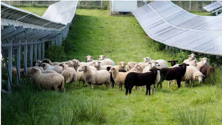
Solarpark Leutkirch der enBW, Inbetriebnahme 2014 Leistung und Fläche: 2,9 MWp auf 6,9 ha (3.200 MWh/a)
